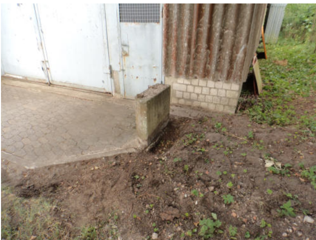
Foto 5: Regenwasserabfluss von Bereich Tankplatz und Pflaster vor Windenhalle
