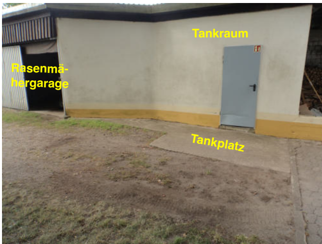
Foto 1: Blick nach Südwesten auf den Tankraum und den betonierten Tankplatz
