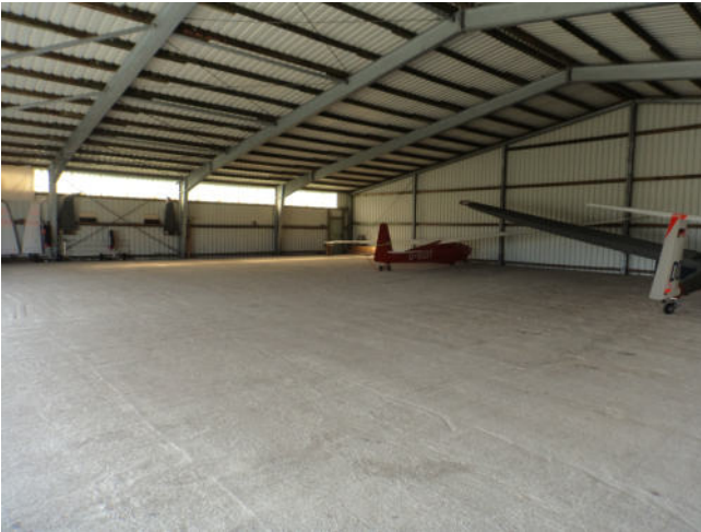
Foto 13: Segelflugzeughalle, Betonboden unauffällig, keine Schadstellen, hier wird auch das Ultralightflugzeug abgestellt und betankt
