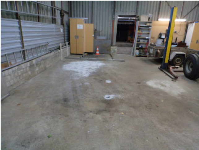
Foto 7: Windenhalle Abstellplatz für LKW mit Winde, Betonboden intakt, wenige Ölflecken, Ölbinder ausgebracht
