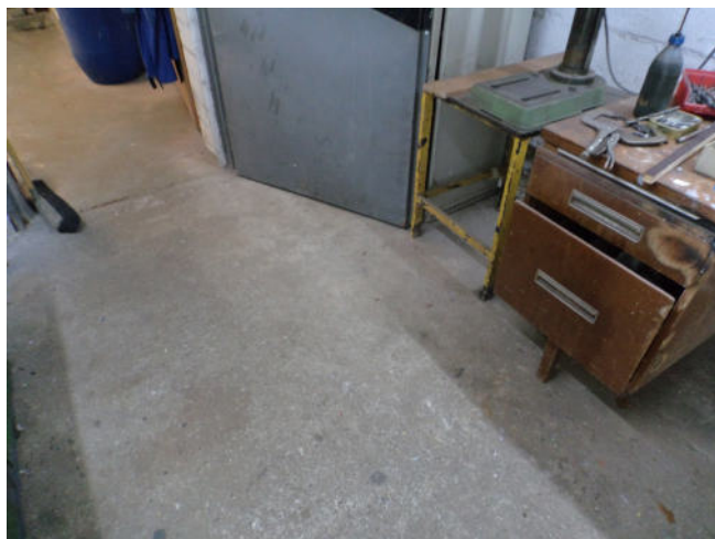
Foto 15: Betonboden Metallwerkstatt, unauffällig, ohne Schadstellen und Verschmutzungen
