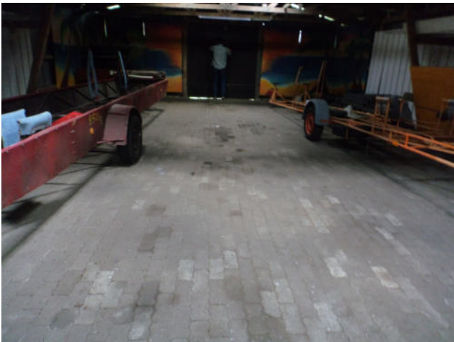
Foto 9: „Pelzhalle“ Winterlager für Flugzeuge mit Holzanteilen, zeitweise werden auch die „Seilhol“-PKW dort abgestellt, wenige Ölflecken auf dem Boden
