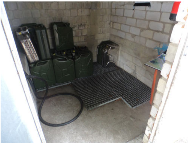
Foto 3: Benzinkanisterlager auf Tropfanggittern im Tankraum
