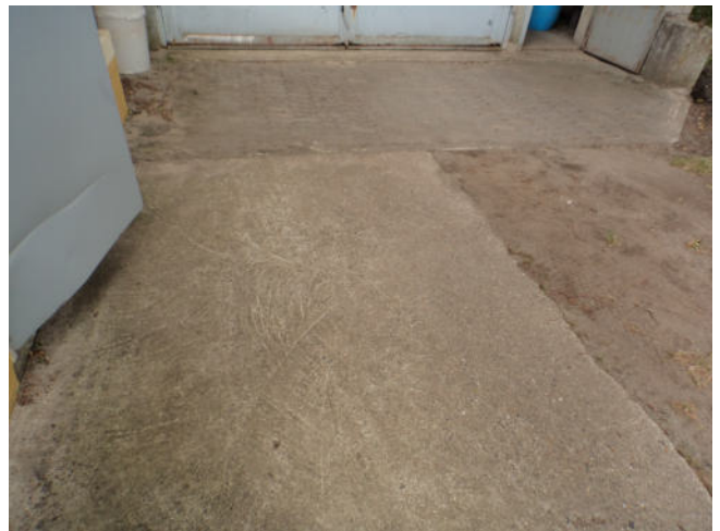
Foto 4: Tankplatz mit Gefälle in Richtung Windenhalle, keine Hinweise auf ausgelaufenes Diesel
