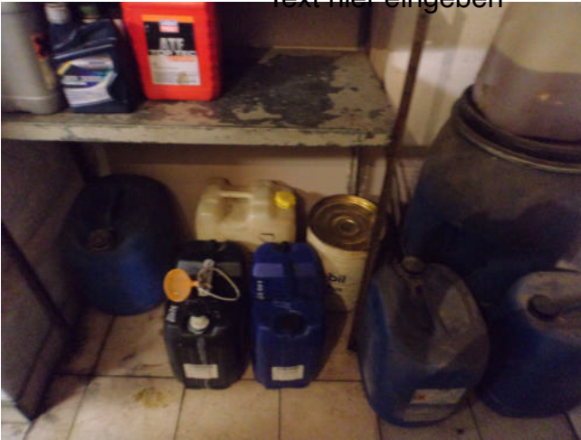
Foto 19: Ölkästen in HEL-Lageraum, mit Fliesen versiegelter Boden.
