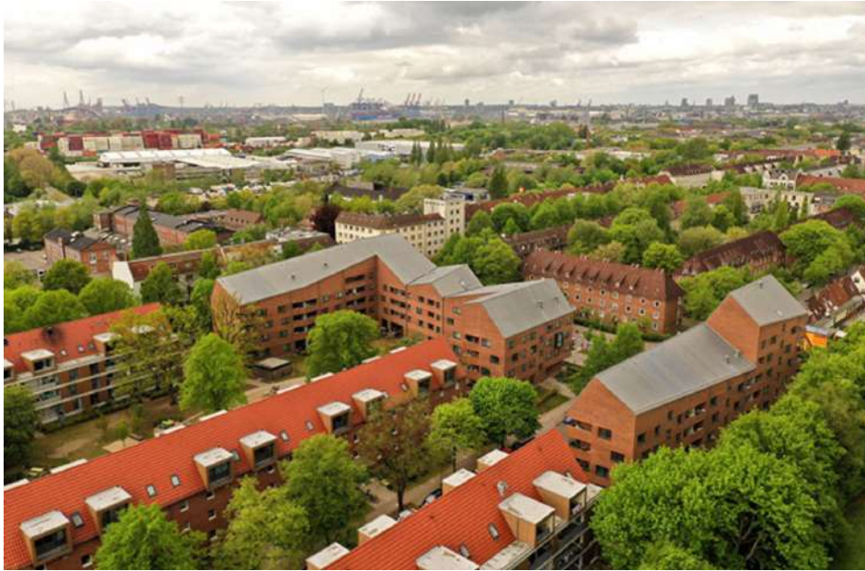
Nachverdichtung, Aufstockung, Dachausbau Vieringstraße Hamburg
