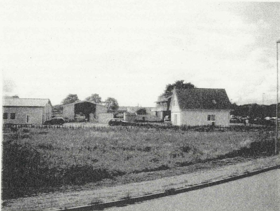
Betriebshof Bauunternehmen (im Vordergrund befindet sich das Betriebsgrundstück eines weiteren Handwerksbetriebes)
